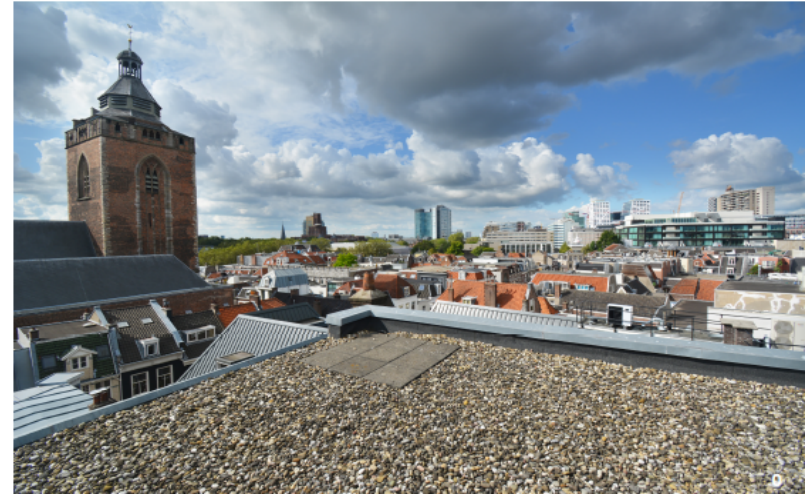
Figuur 6: panorama vanaf het dak
